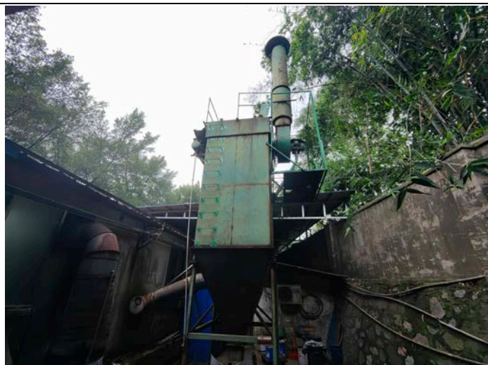
手动开刃粉尘布袋除尘器
